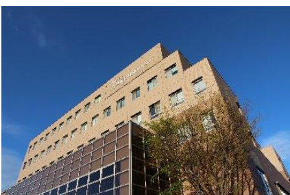
平成16年新築2期工事竣工
